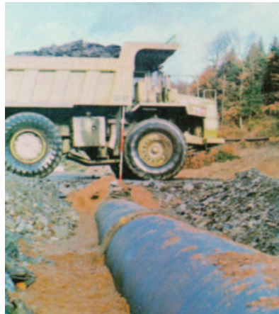
Sicherheit auch bei geringer Grabentiefe und hohen Verkehrslasten
