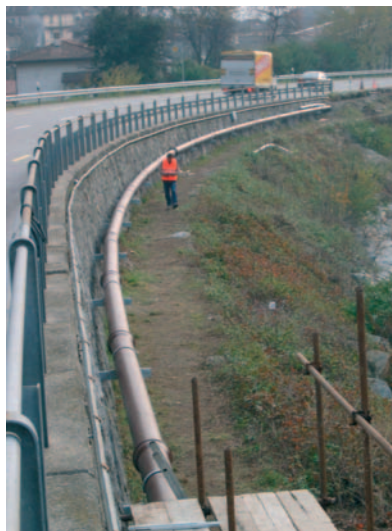
Die Rohrleitungen kommen dank Auslenkung in der Muffe ohne zusätzliche Formstücke aus und sparen so Kosten.
