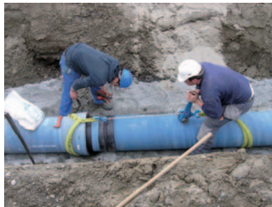
Einfache und rasche Rohrmontage mit Steckmuffenverbindungstechnik.
