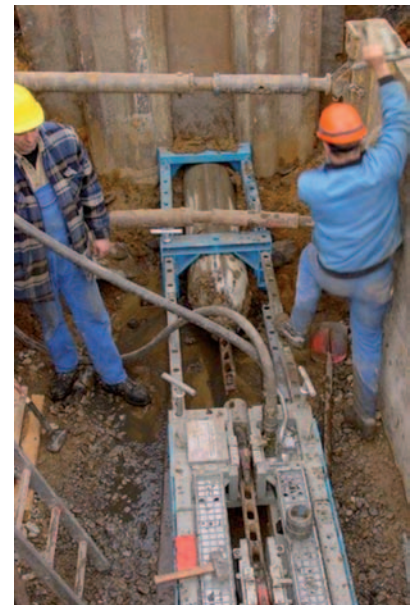
Duktile Gussrohre sind prädestiniert für den grabenlosen Rohrleitungsbau.
