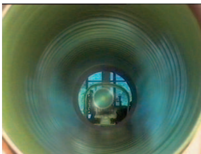
Innenbeschichtung der duktilen Gussrohre mit Polyurethan.
