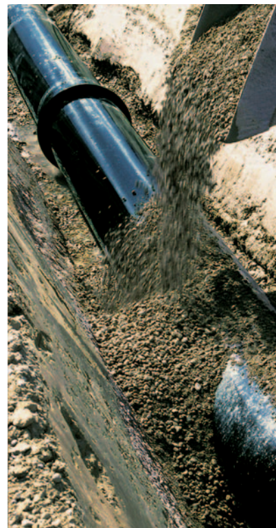
Duktile Gussrohre mit schlagfester Umhüllung können wirtschaftlich und umweltschonend mit Aushubmaterial eingebettet werden.
